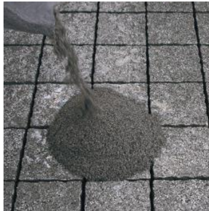
Découper le sac sous vide et verser le matériau frais sur la surface du revêtement.
