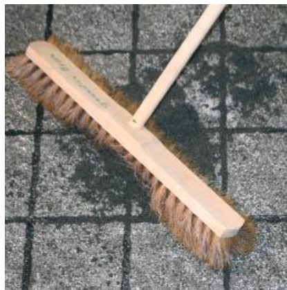
Éliminer entièrement les restes de mortier de la surface du revêtement avec un balai doux.
