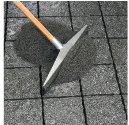
Introduire PCI Pavifix® 1K Extra dans les joints à l'aide d'une raclette en caoutchouc.
